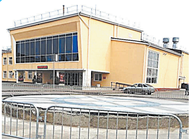
В станице Вёшенской завершён первый этап благоустройства у районного Дворца культуры. Здесь были проведены работы по устройству водоснабжения, установлено оборудование фонтана, оборудована автостоянка. На следующем этапе появятся зона отдыха, лавочки, дорожки для велосипедистов, пешеходов, зелёные насаждения
