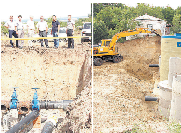
Завершено строительство водопровода и разводящих сетей в ст.Базковской. На завершающем этапе реконструкция водопровода в станице Вёшенской
