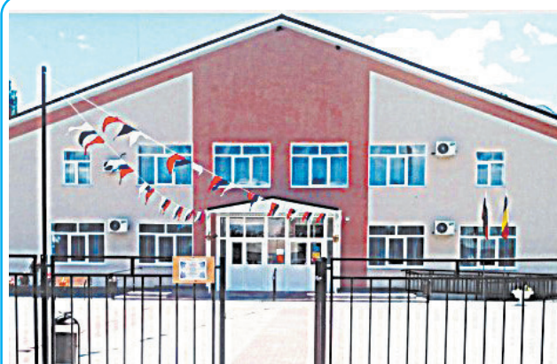
В хуторе Кружилинском проведён капитальный ремонт сельского Дома культуры
