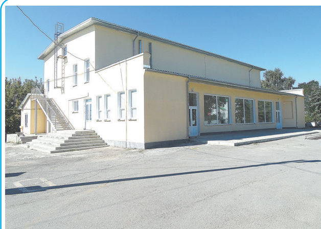
Отремонтировано здание патриотического центра (бывший кинотеатр «Колос»)
