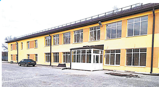
Калининская школа, построенная ещё в 1975 году, давно требовала обновления. Сейчас её ремонт завершён. Теперь здание не узнать, а во дворе появились спортивная площадка и игровая зона
