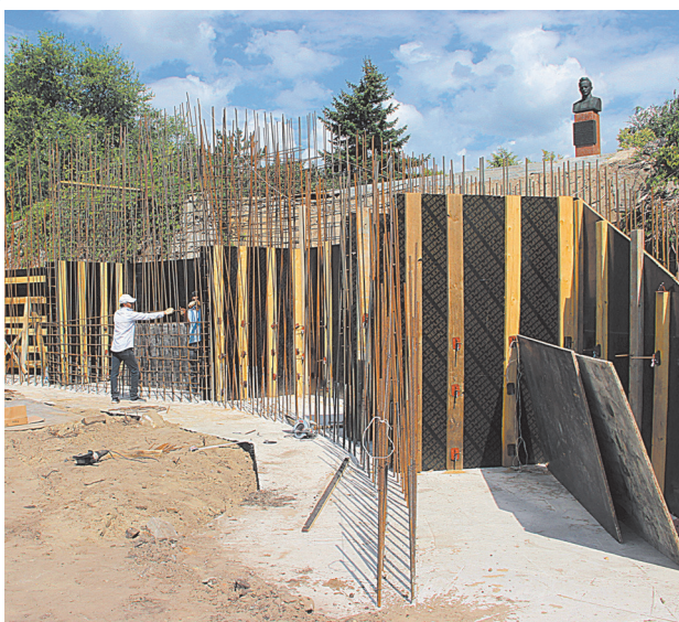
Продолжается благоустройство центральной части станицы Вёшенской. Строительные работы проводятся на набережной Дона
